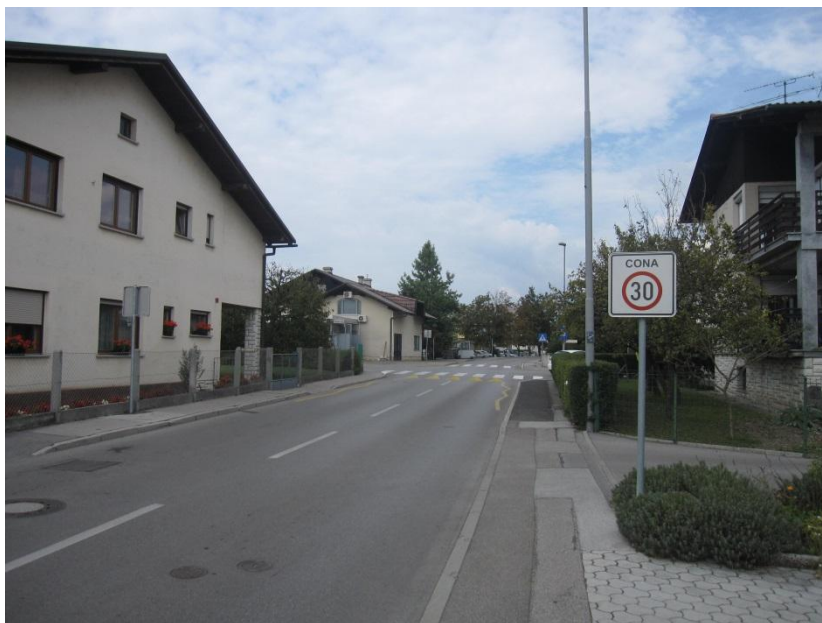
Slika 19: začetek in konec cone 30 Km/h na Češminovi ulici.
